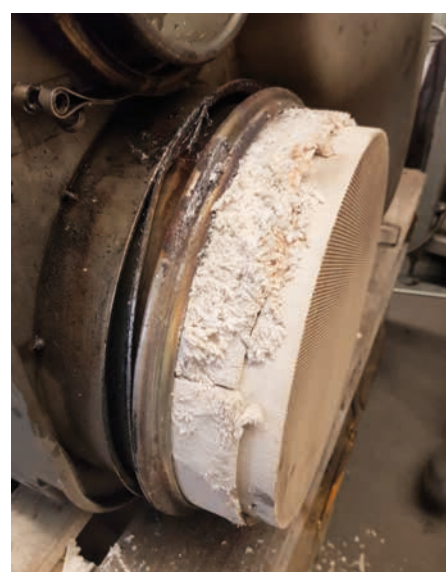
Hier kommt jede Hilfe zu spät. Der Betreiber hat die Reinigung zu lange aufgeschoben. Der Gegendruck wurde so hoch, dass sich die Keramik verschoben hat. Schaden ca. 11.000 Euro.
